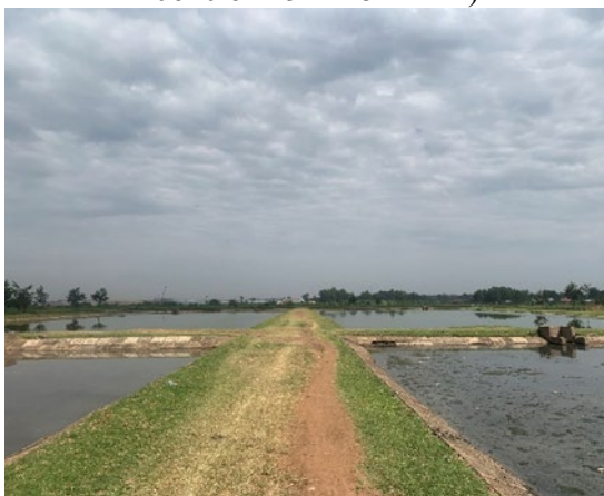
(e) Doho WWTP (36N 627991.07 118705.44 1104.35 m.a.s.l)
